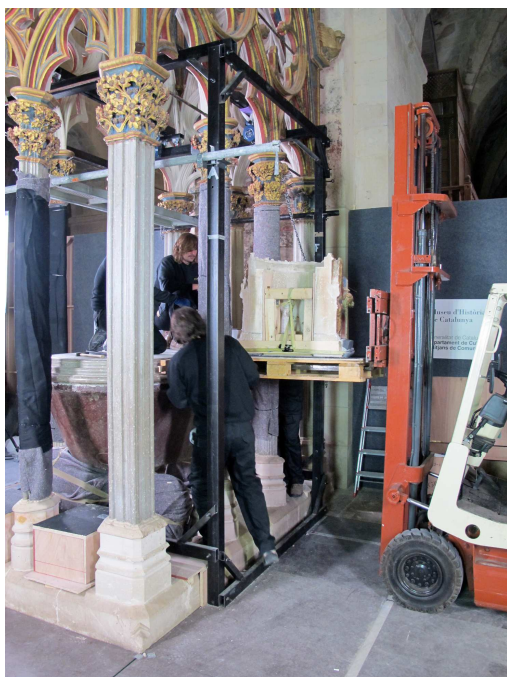
Tasques de desmuntatge del temple i per a ser restaurat en el taller expressament instal·lat al mateix monestir. MHC / J. Chillida.
