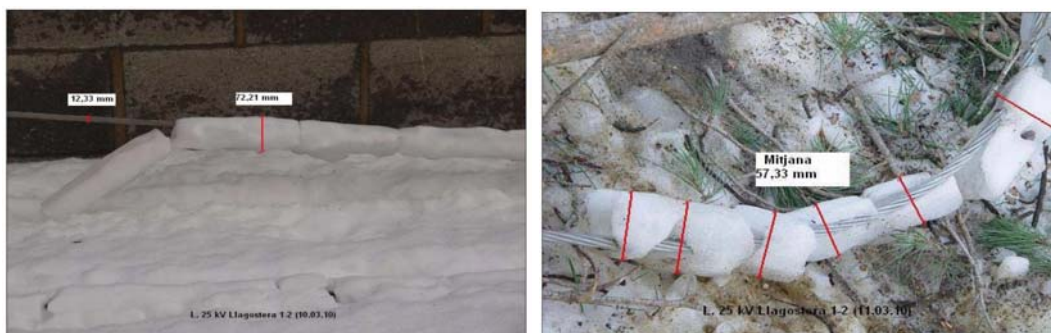
Imatges de maneguts de gel en una línia de 25 kV
