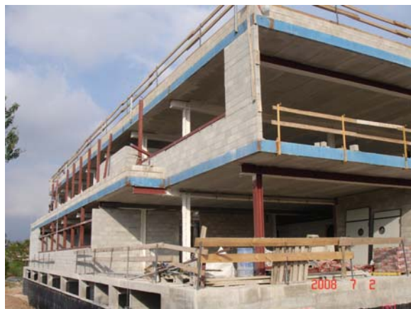
Estat de les obres de la comissaria de Gandesa (juliol de 2008)
