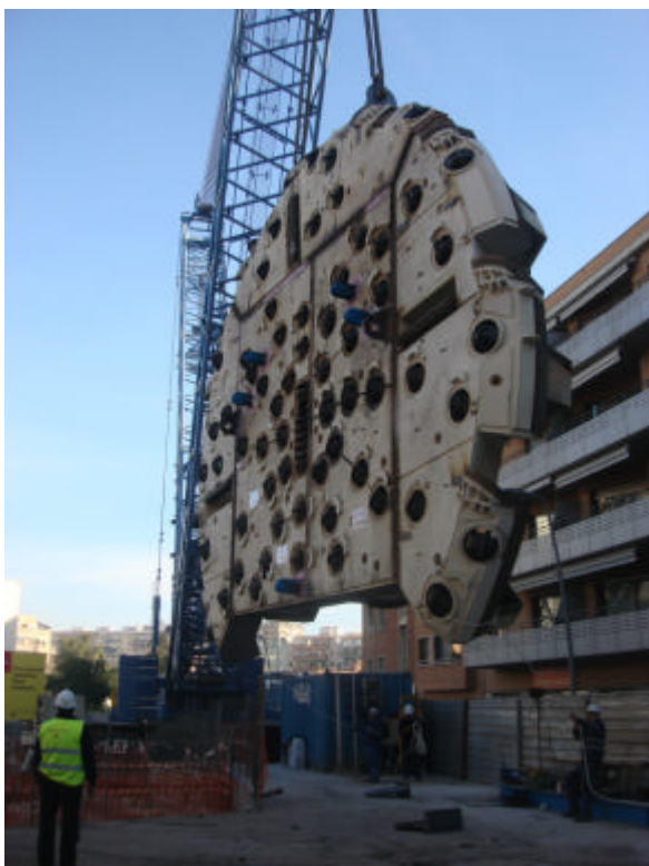
Imatge de la introducció del nou capçal al pou de la plaça de les Havaneres
