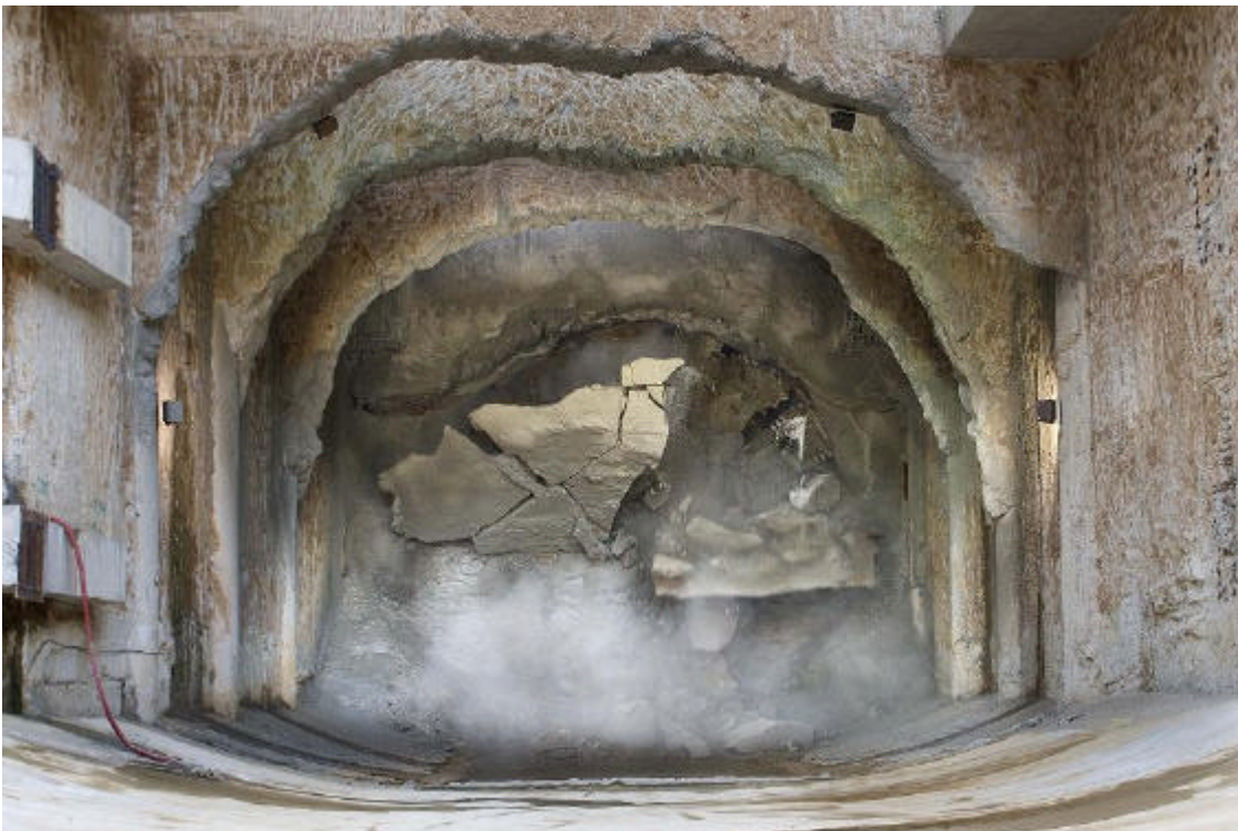
Calada de la tuneladora al macropou
