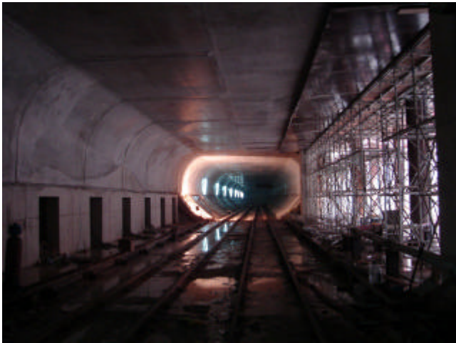
Túnel i estació
