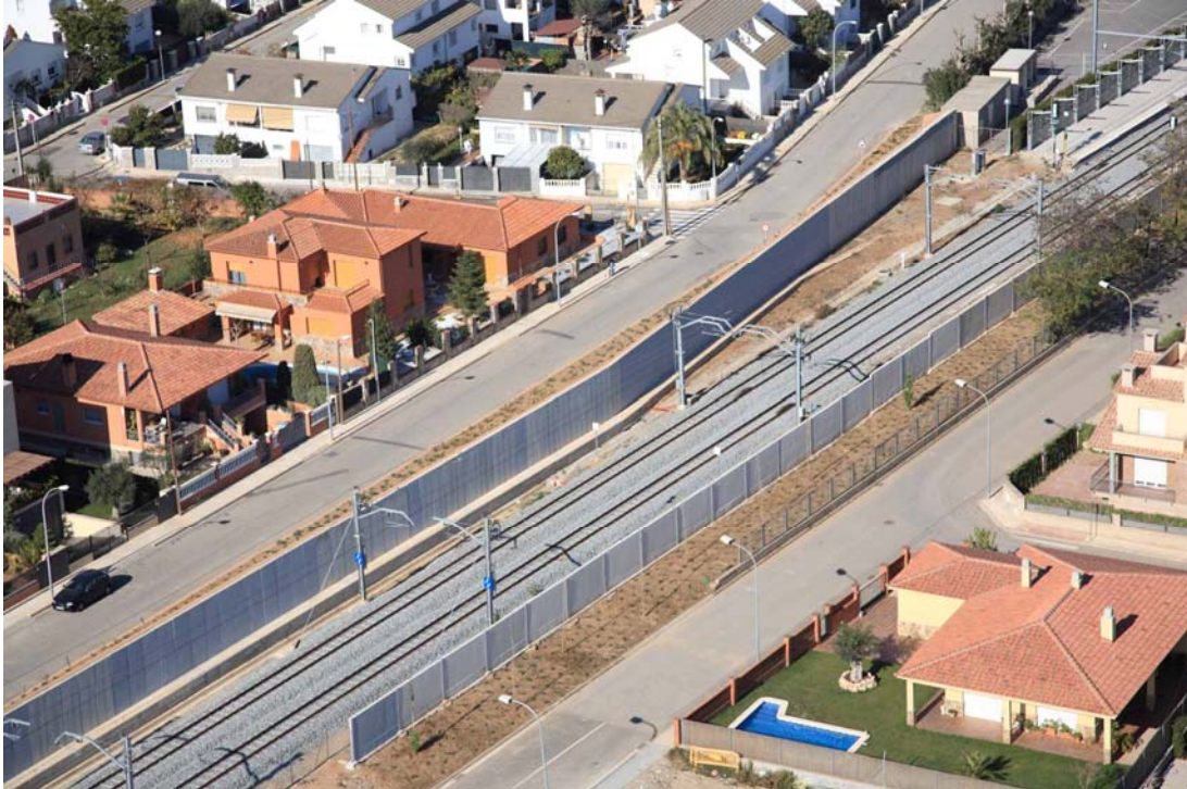
Barreres acústiques a Abrera
