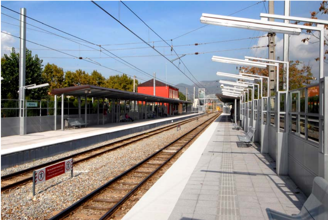
Estació remodelada d'Abrera
