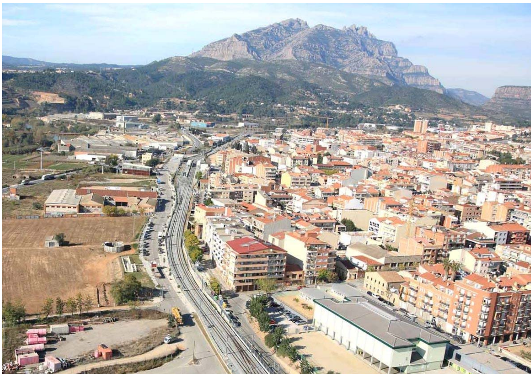
Imatge aèria del desdoblament de la línia
