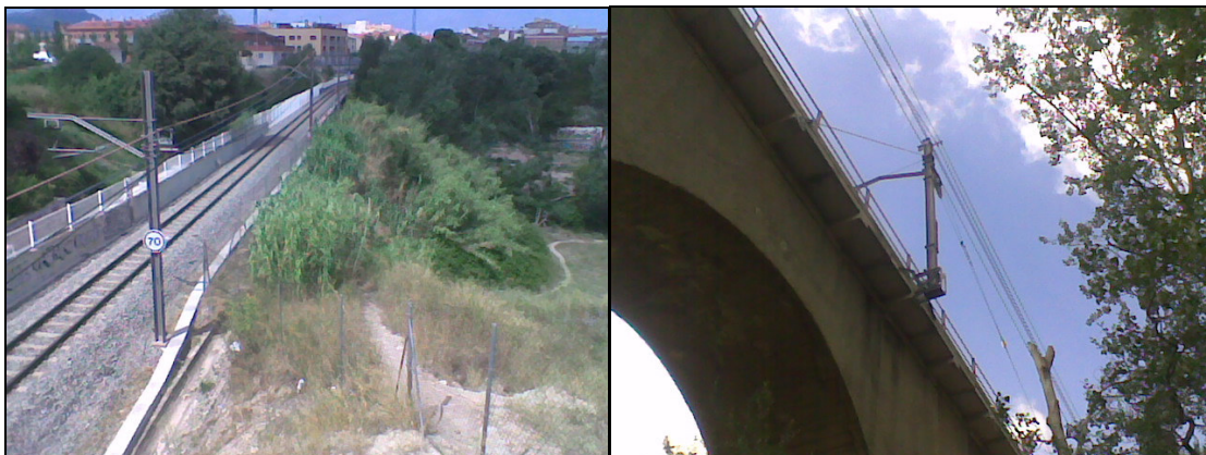
Vistes del pont actual de FGC al seu creuament amb la riera d'Òdena
