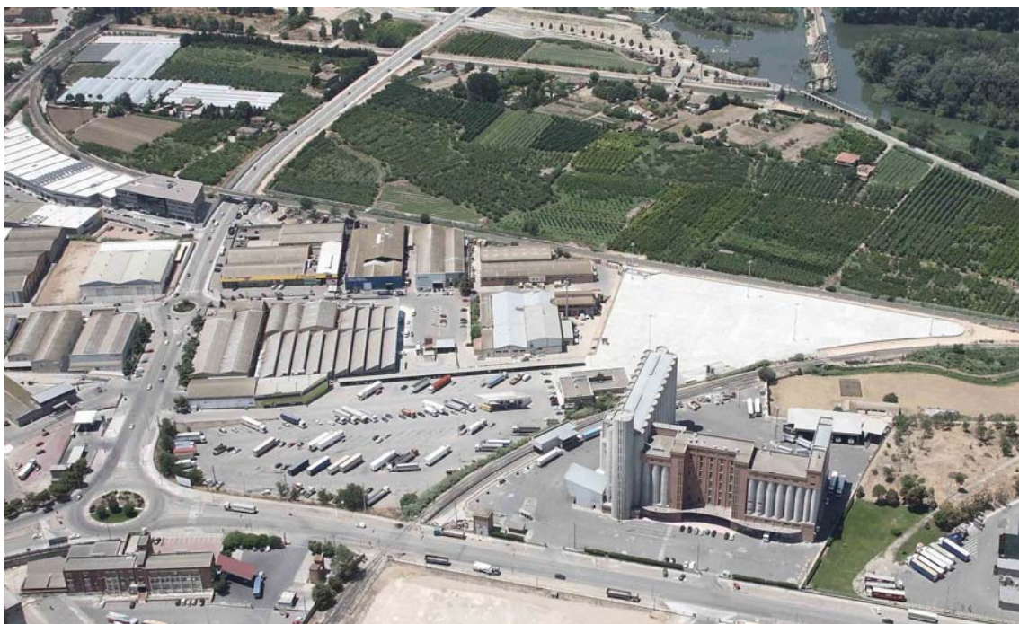
Imatge aèria de l'espai adjacent condicionat al costat de l'aparcament existent
