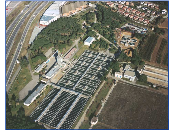
PARC FOTOVOLTAIC ETAP TER MODULS SOBRE INSTALLACIONS
