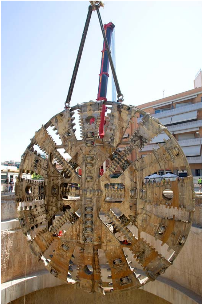
Extracció del capçal de la tuneladora
