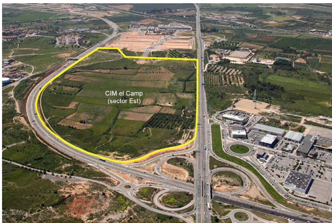
Fotografia dels terrenys on es construirà la segona fase de la Cim El Camp
