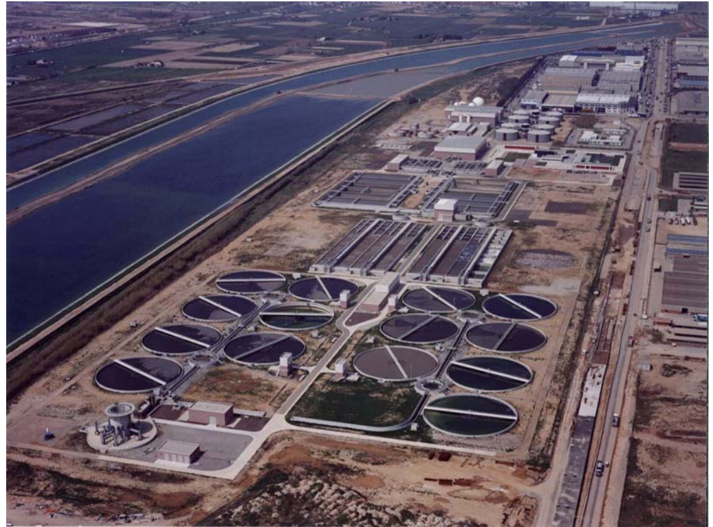
Vista aèria de la depuradora del Baix Llobregat
