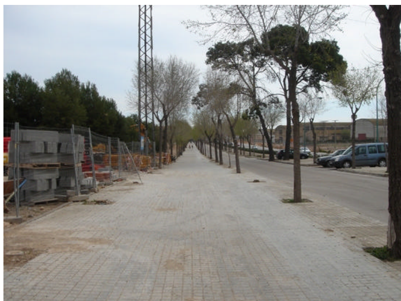
Remodelació de carrers al barri de Campclar, Tarragona
