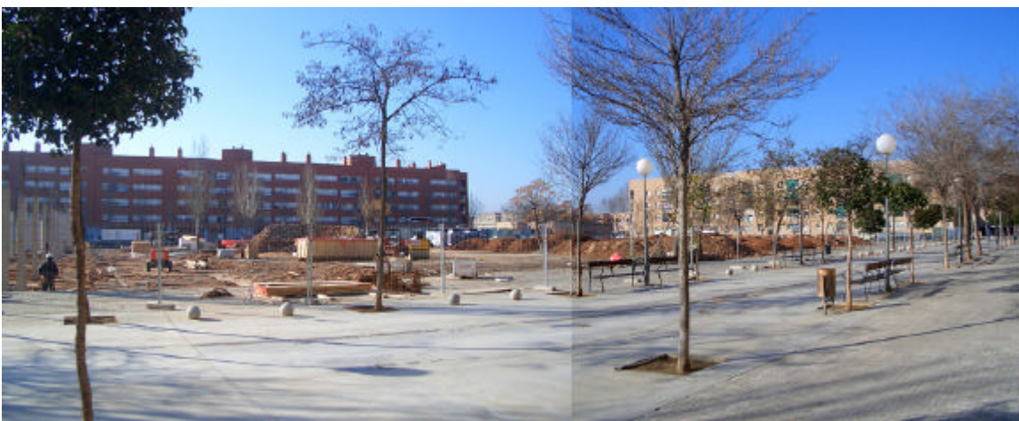
Urbanització de la plaça dels Jutjats, el Prat de Llobregat
