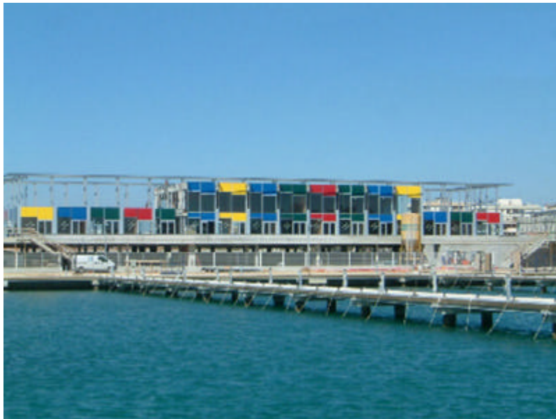
Locals comercials; botigues efectes nàutics, nàutiques i restauració
