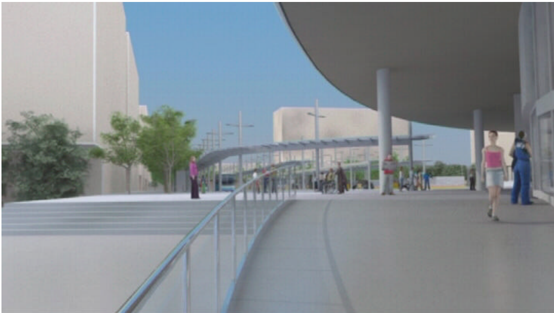
Rampa d'accés a l'àrea d'autobusos i taxis des del nucli urbà
