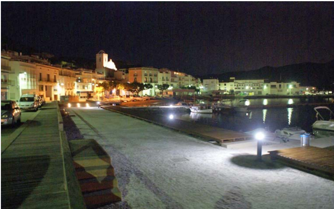
Nou enllumenat a les instal·lacions portuàries
