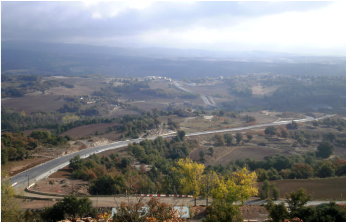
Vista general de l'obra, a Prats de Lluçanès
