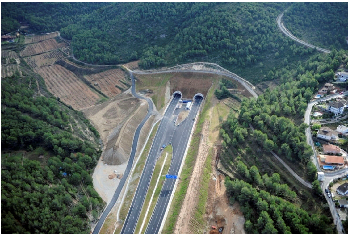
Túnel del Montgros, boca Canyelles
