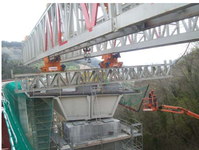
Execució del viaducte de Sant Bartomeu
