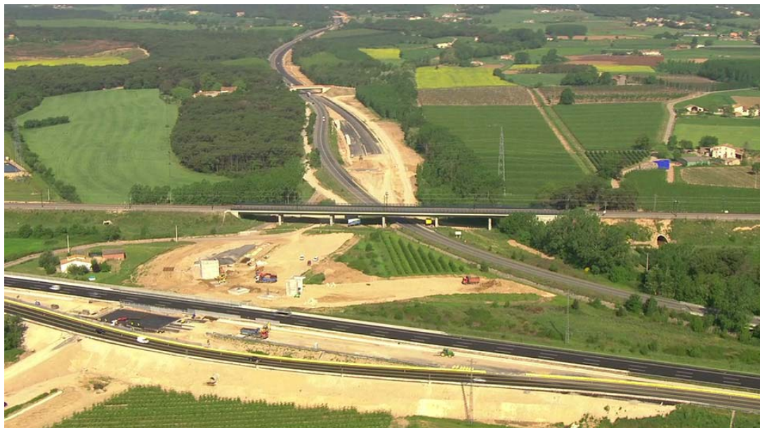
Tram final de l'obra
