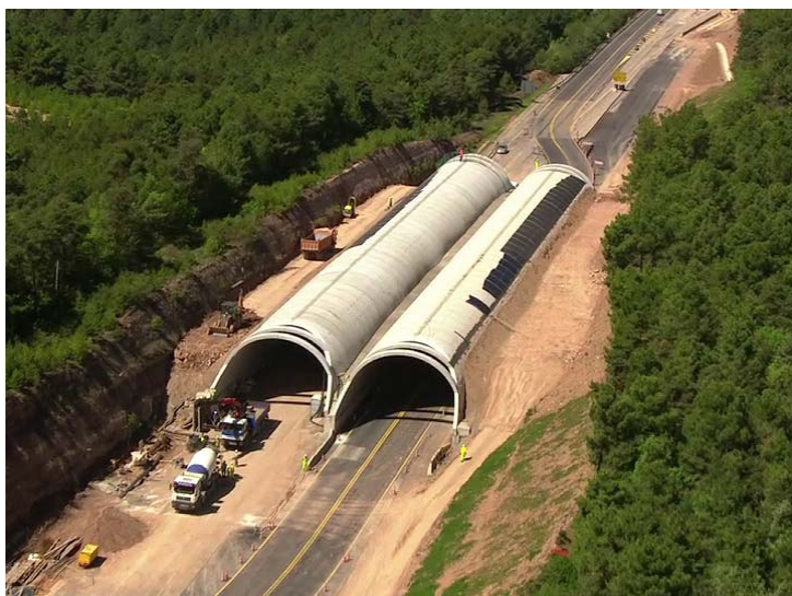
Ecoductes que permetran el pas de fauna a un costat i altre de l'autovia, entre Muntanyola i Santa Maria d'Oió
