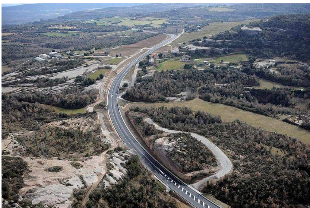
Actuació a l'entorn de Sagàs
