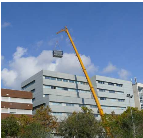
Instal·lació de l'equipament amb camió grua
