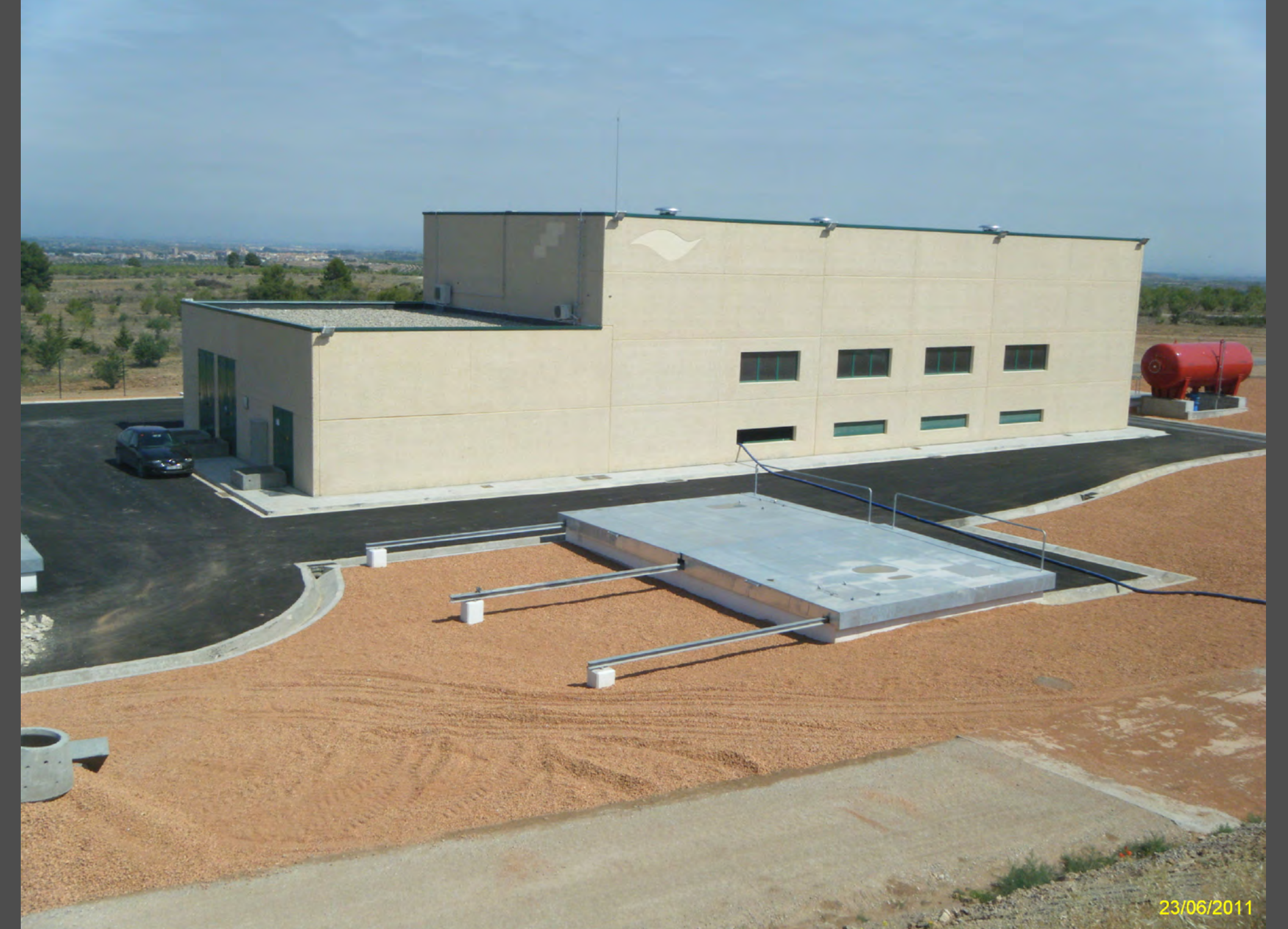
Sector 9.1. TM Borges Blanques. Estació de bombament.
