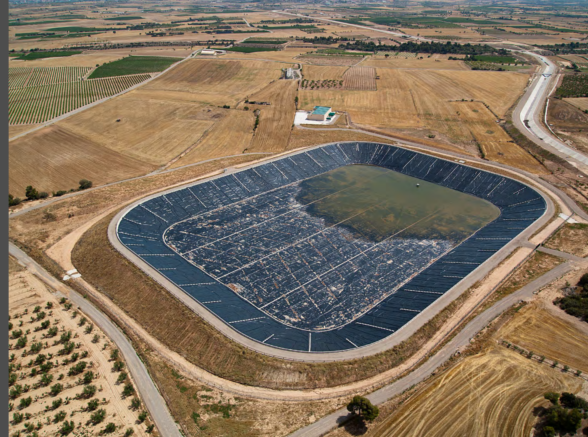
Sector 6. TM Verdú. Canal, EB i Bassa reguladora.
