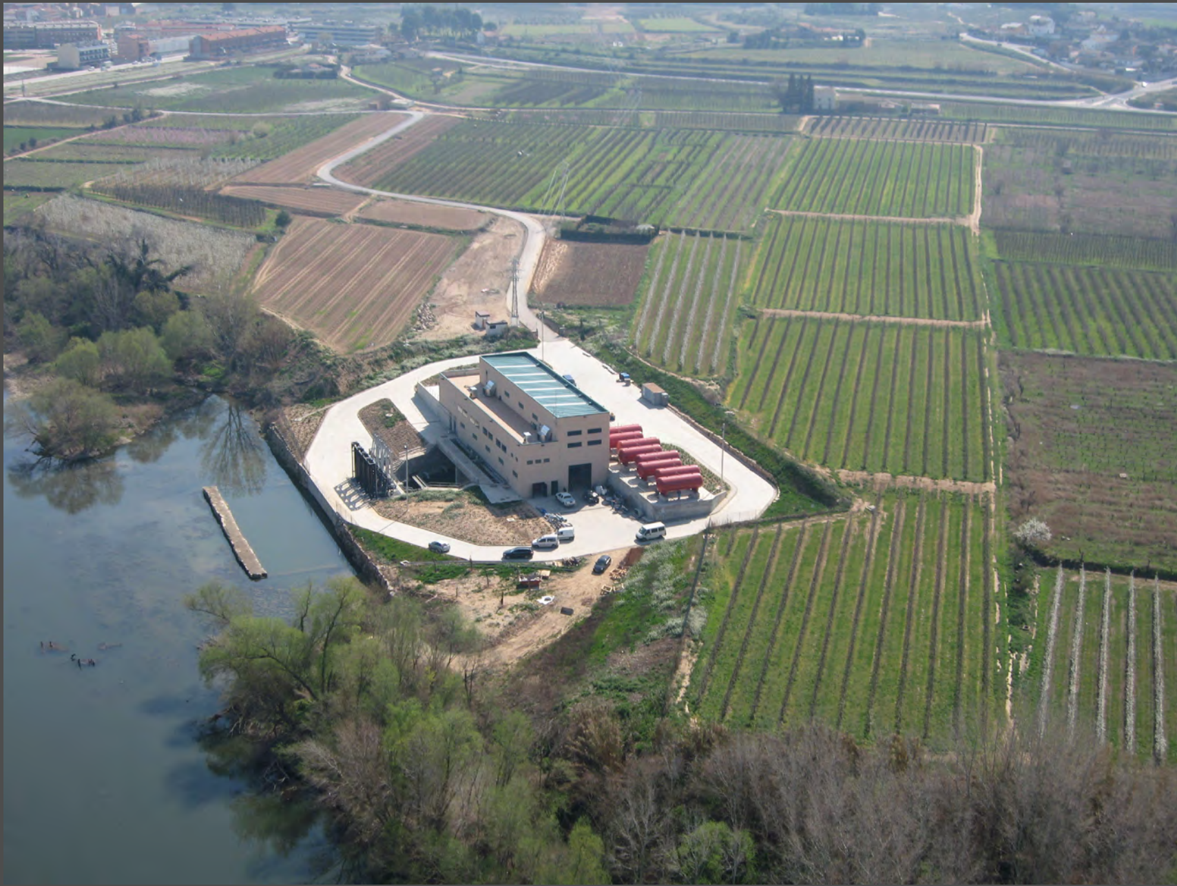
Sector 12. Captació Riu Segre. Obra finalitzada.
