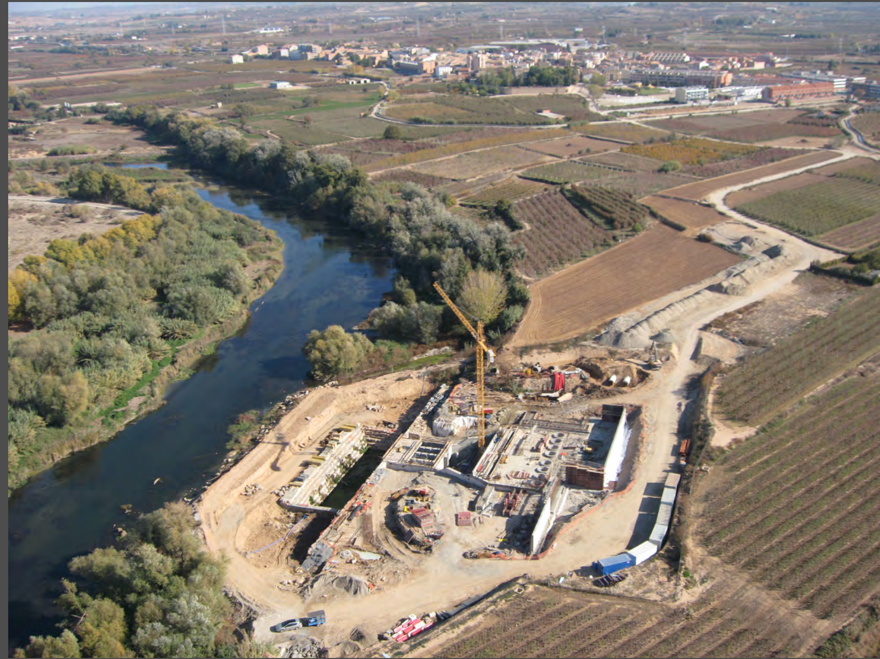
Sector 12. Captació Riu Segre. Execució.
