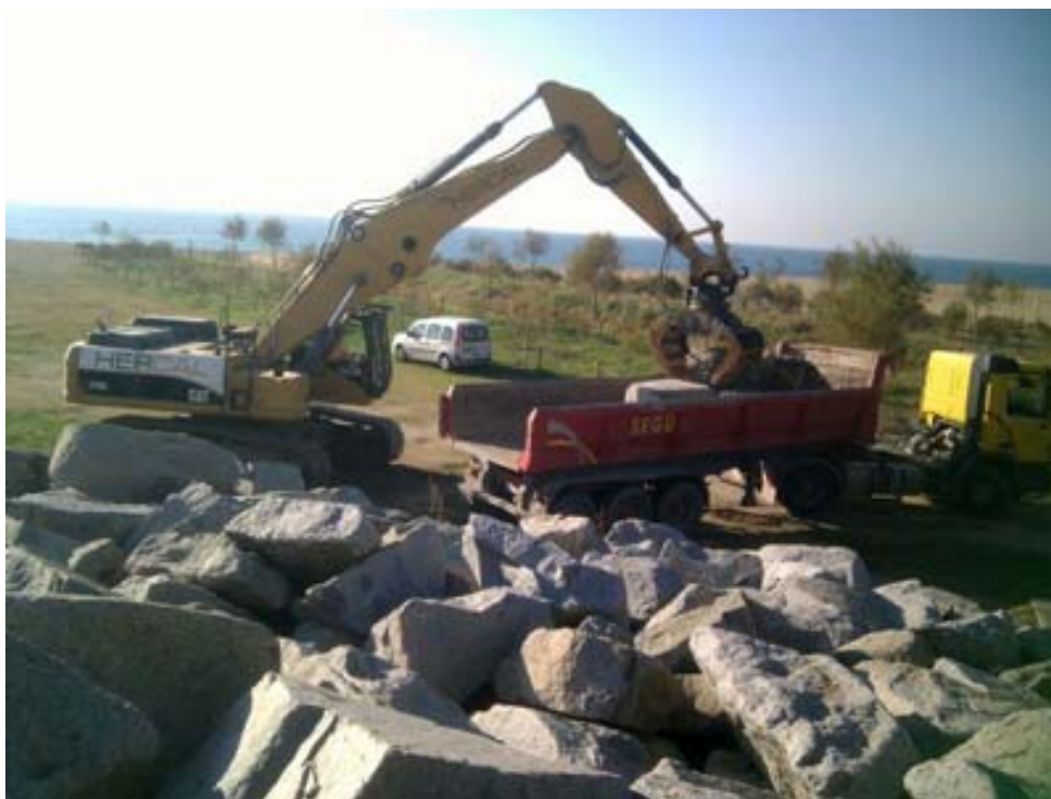
Desmuntatge de l'escullera iniciat avui
