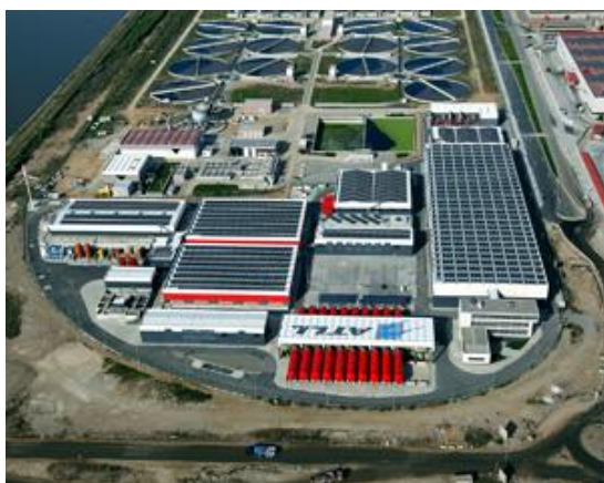
Dessalinitzadora del Llobregat i, al fons, depuradora del Llobregat
