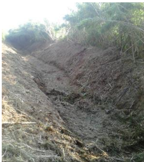
Estat de la llera durant els treballs
