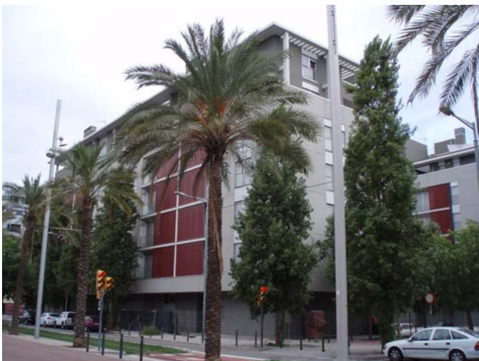
Edifici Illa L
