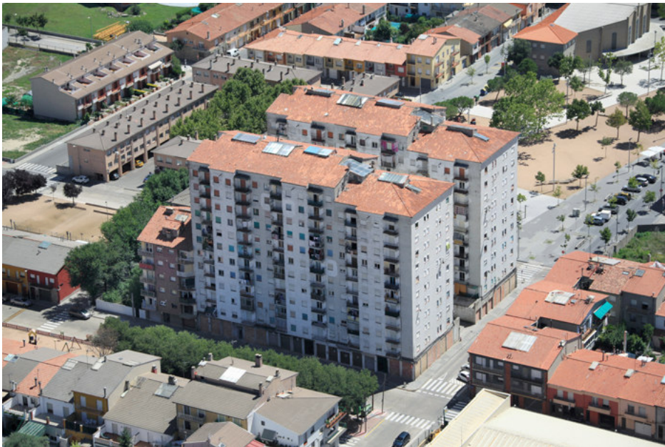
En primer terme, el bloc que s'enderrocarà inicialment
