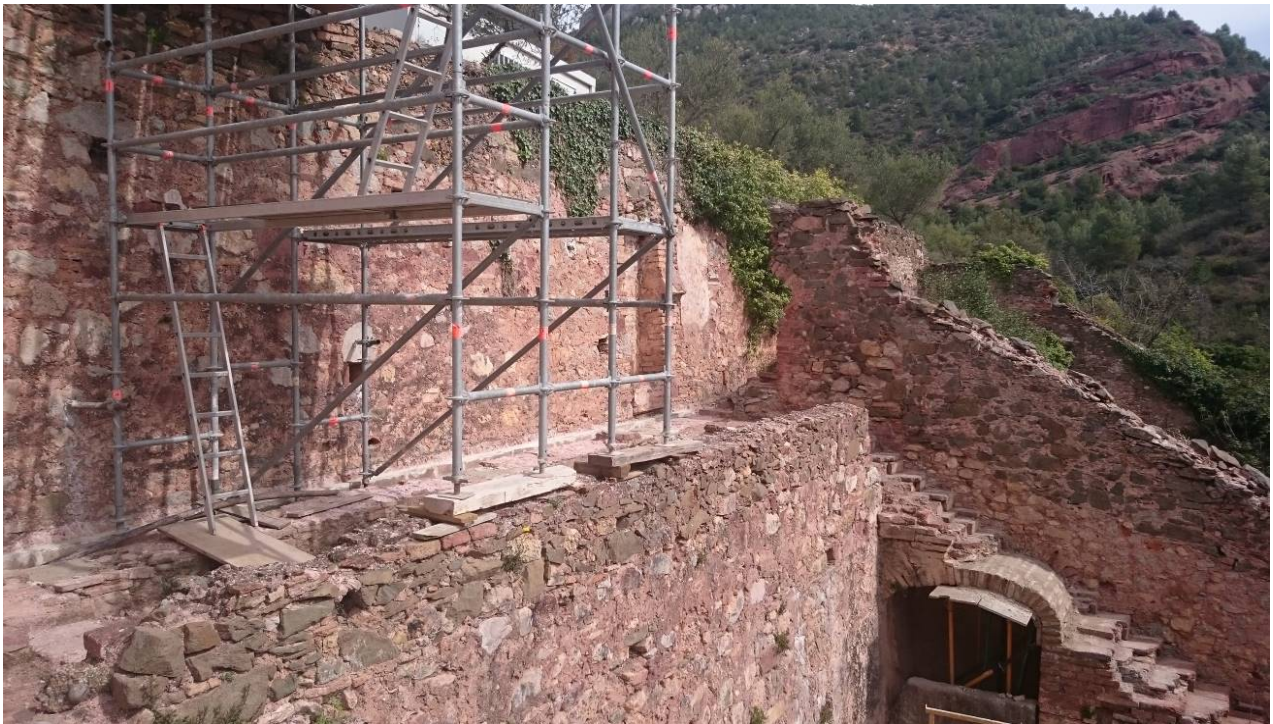
Obres en curs al mirador de la cel·la C de la Cartoixa d'Escaladei. La finalització de l'adequació del mirador, juntament amb el projecte museogràfic tindrà lloc el mes de juliol de 2015
