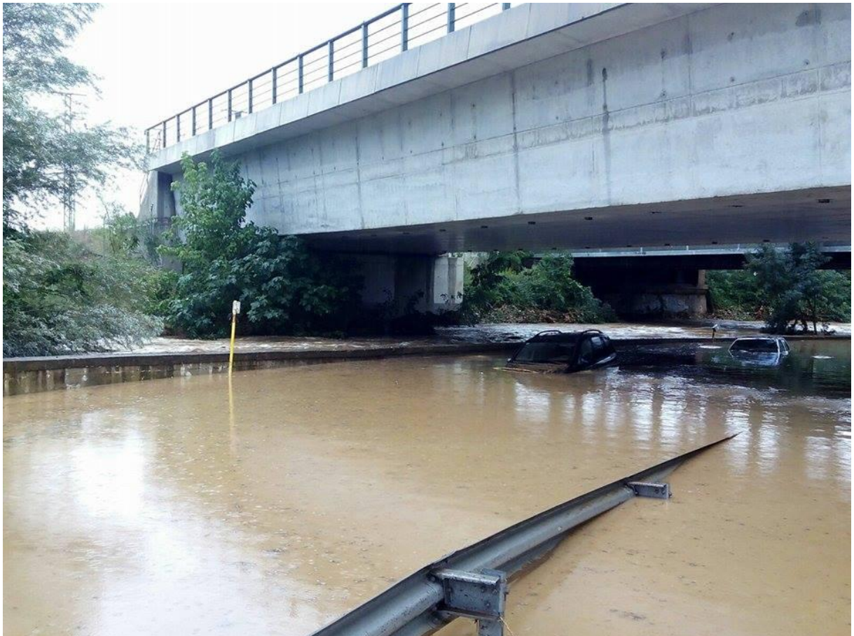
Pont de l'estació de Breda (14/08/2015)
