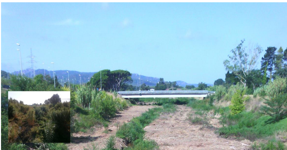
Estat de la llera després dels treballs (en el requadre, mateix tram abans de l'actuació)
