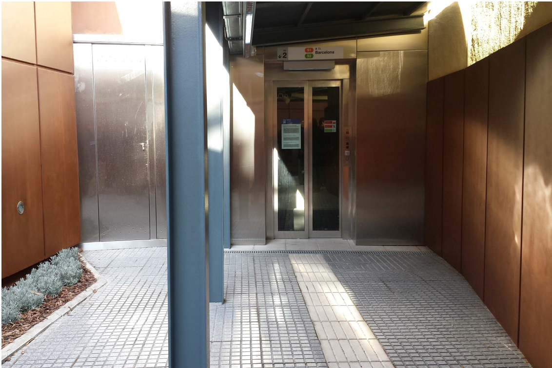
Entrada del nou ascensor de l'estació de Peu de Funicular que permet arribar a l'andana sentit Barcelona.
