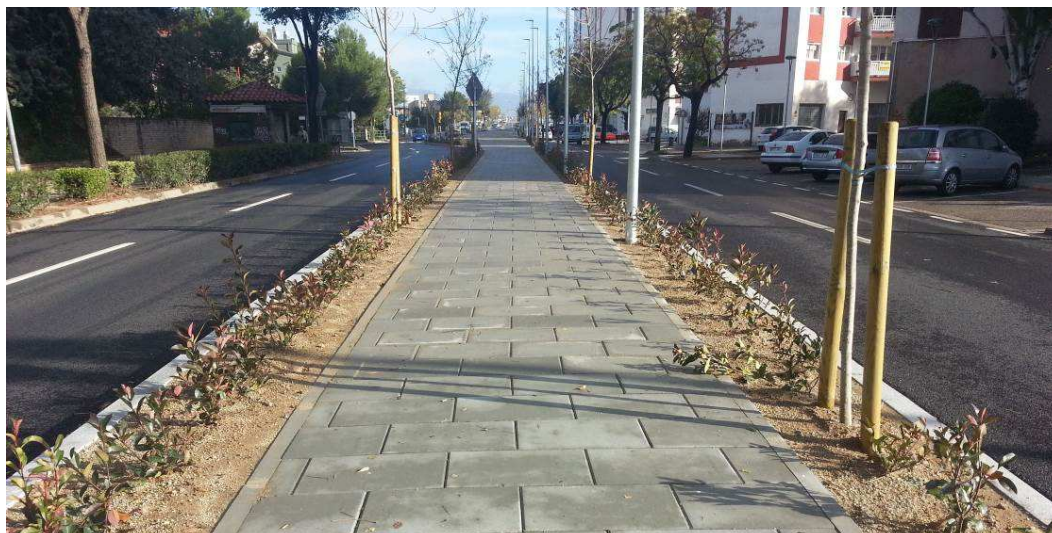
Nova Rambla formada al tram intermedi de la travessera.
