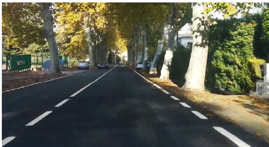
Repavimentació de la C-246.
