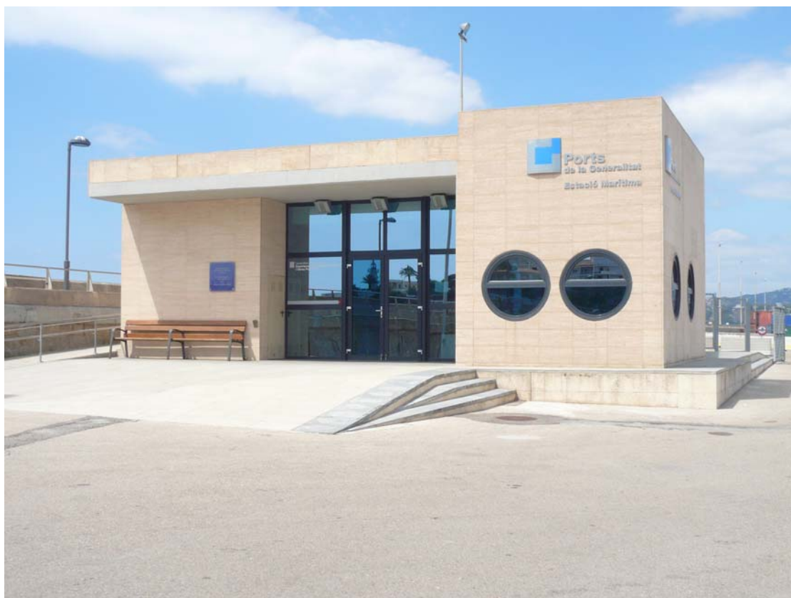
Estació marítima del port de Palamós
