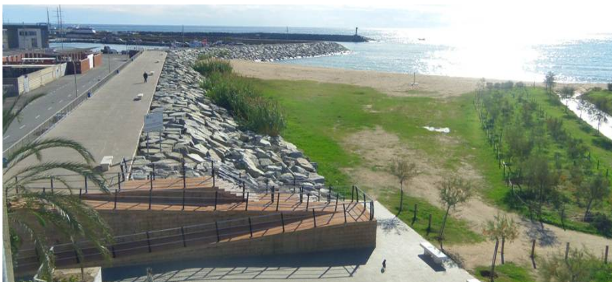
Zona d'obres del projecte del port d'Arenys de Mar
