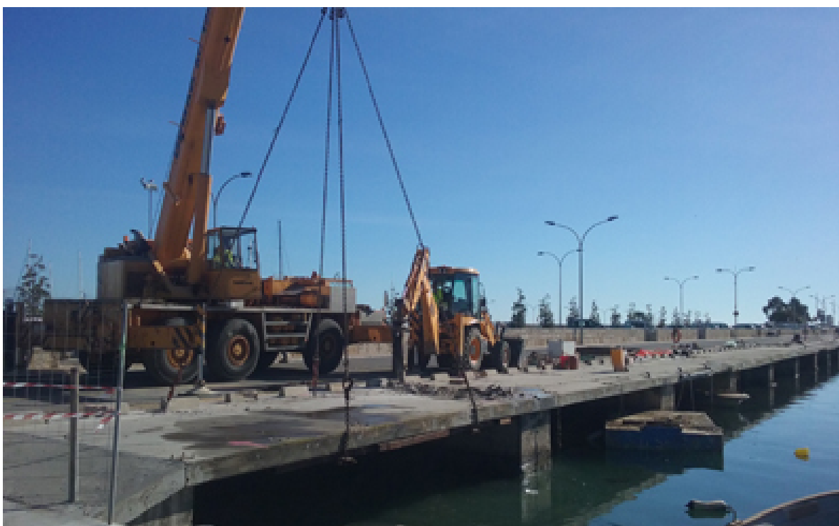
Desmuntatge de la superfície del moll pesquer
