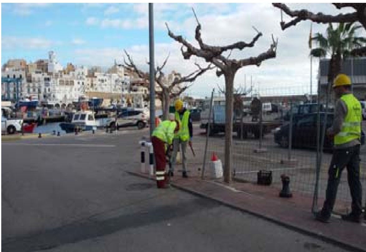
Obres al port de l'Ametlla de Mar
