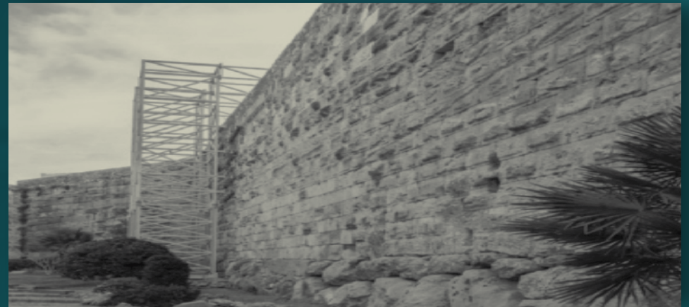
Restauració de part de la muralla romana (Tarragona, 2015)
