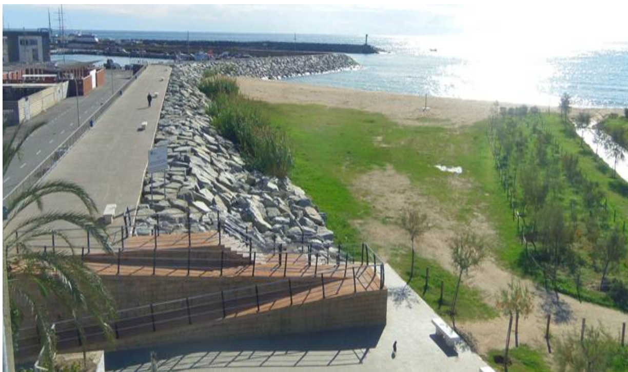
Zona on s'executaran les obres del port d'Arenys de Mar
