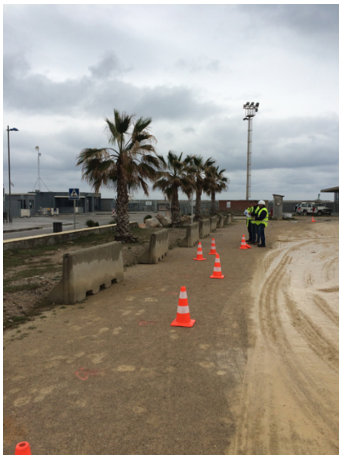
Inici d'obres a la zona de ponent del port de Vilanova
