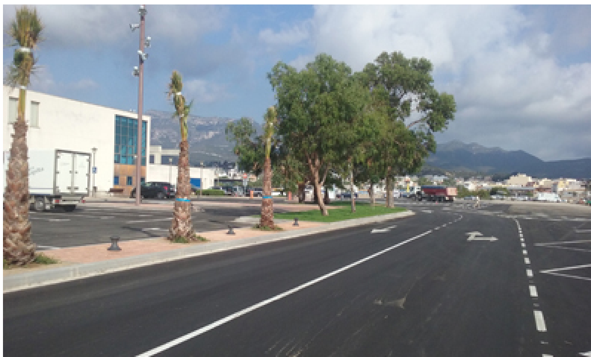
Urbanització entorn a la llotja de peix de Sant Carles de la Ràpita
