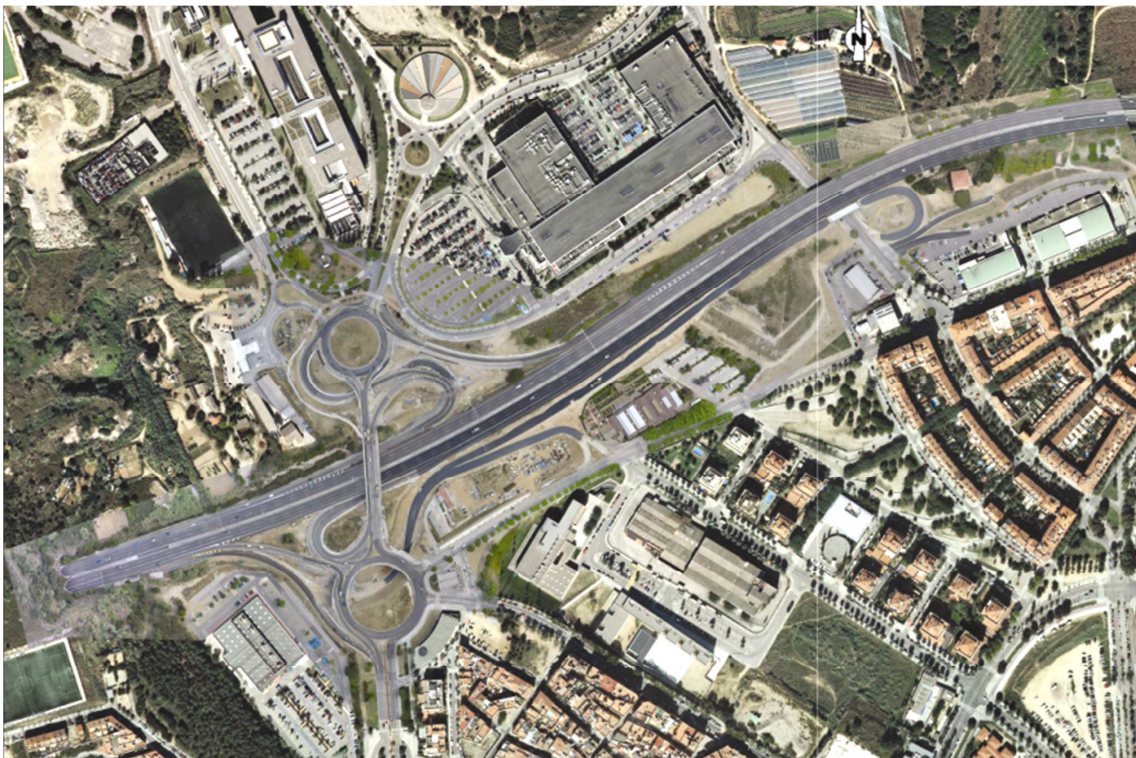
Imatge aèria del nou enllaç de Mataró Oest.
