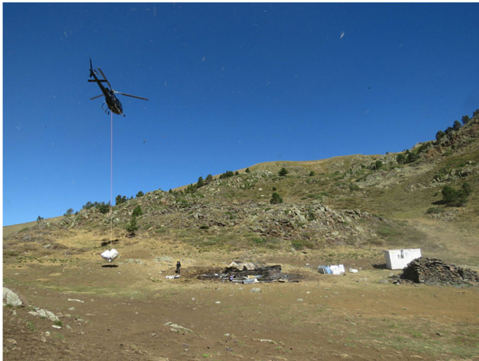
Moment de la col·locació del refugi.
