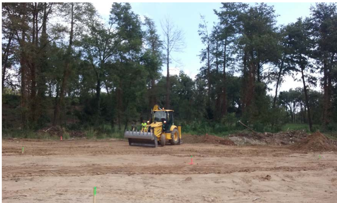
Inici de les obres de la depuradora d'Avià.
