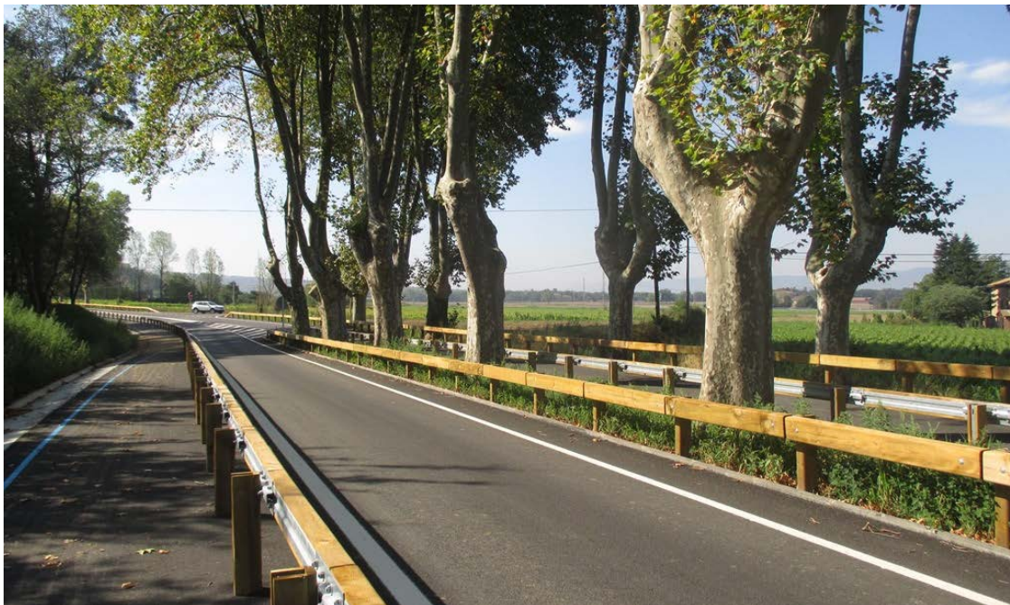
Via verda de la BV-5202.
