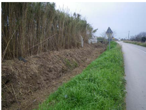
Actuació de lleres duta a terme recentment a Malgrat de Mar.
