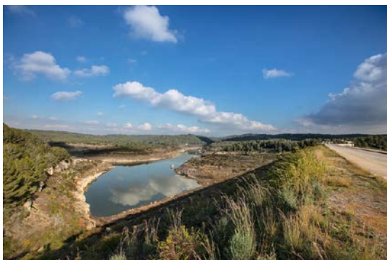
Imatge actual de l'embassament del Catllar.
