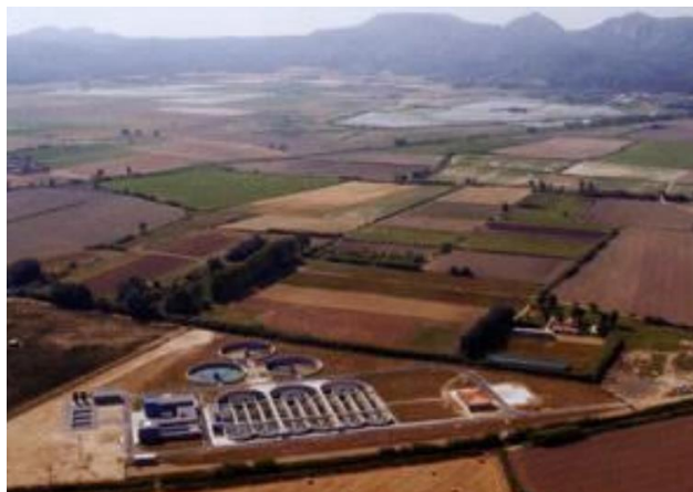
Depuradora de l'Escala.
