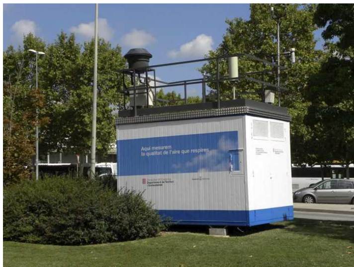
Cabina de mesura de la qualitat de l'aire ubicada a Terrassa.
