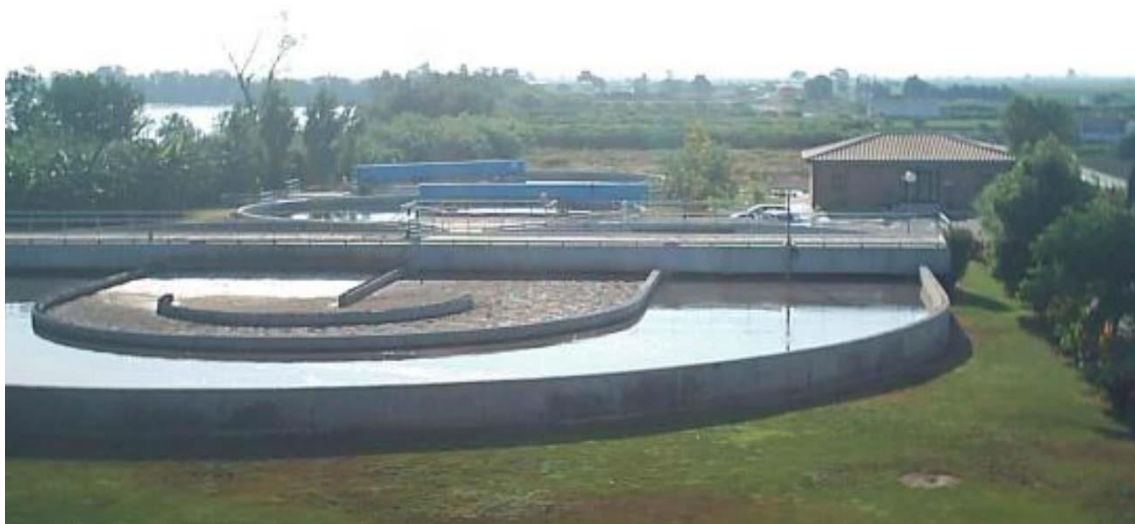
Depuradora d'Amposta, en servei des de 1997 i gestionada pel Consell Comarcal.
